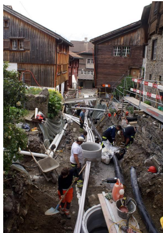
Bau- und Archäologiearbeiten im Leitungsgraben(Foto: KASG).
